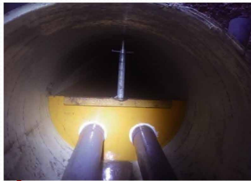
浮上防止工 (供用水を貯留)
