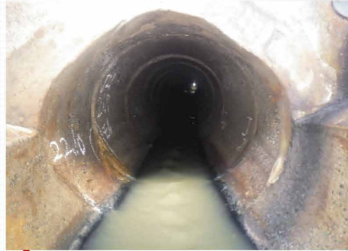
施工前 (既設管)
