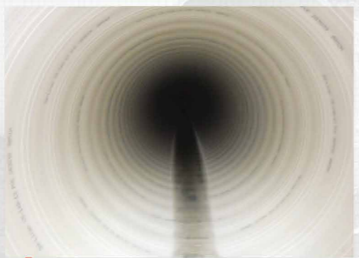
施工後 (更生管)
