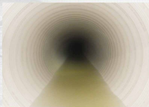
施工後 (更生管)
